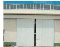
Sliding door (steel frame+color steel sheet)
